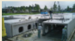
(プレキャスト部材据付工/組立工)
