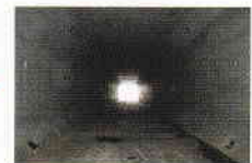
推進完了後の函路
