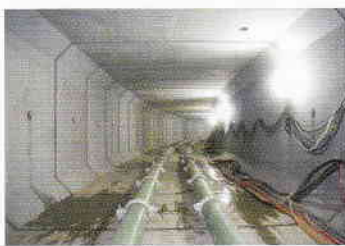
推進中の函体状況(曲線部)
