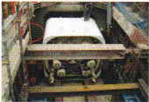
掘進機立坑内掘付完了
