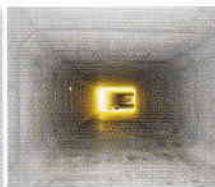
函体コンクリート(曲線部)
