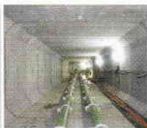
推進中の函体状況(直線部)
