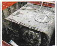
掘進機到達状況
