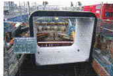
ボックスカルバート投入状況
