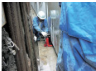
7. ジャッキ操作状況
