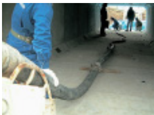
8. モルタル充填状況-1
