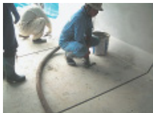
9. モルタル充填状況-2
