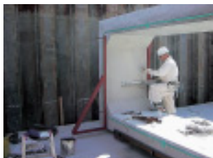
4. 転倒防止装置、ガイド治具セット
