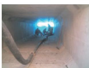
11. 充填モルタル工-1
