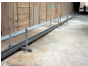
2. レール設置工-1
