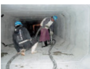
12. 充填モルタル工-2
