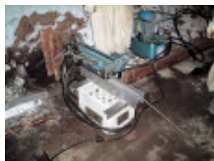
6. 電動チルホール設置
