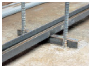
3. レール設置工-2
