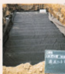
3 排水シート敷設
