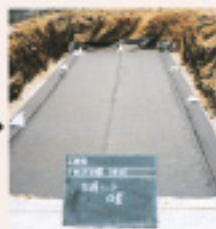
2 保護シート敷設
