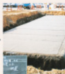
7 排水シート、保護シート敷設完了
